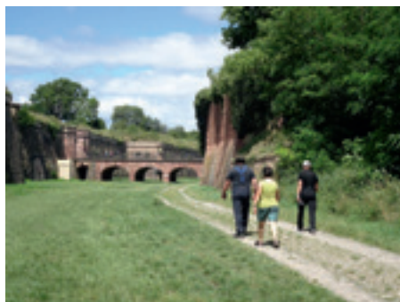
Die Wallanlagen in Neuf-Brisach, Fotos: H. Kerutt
